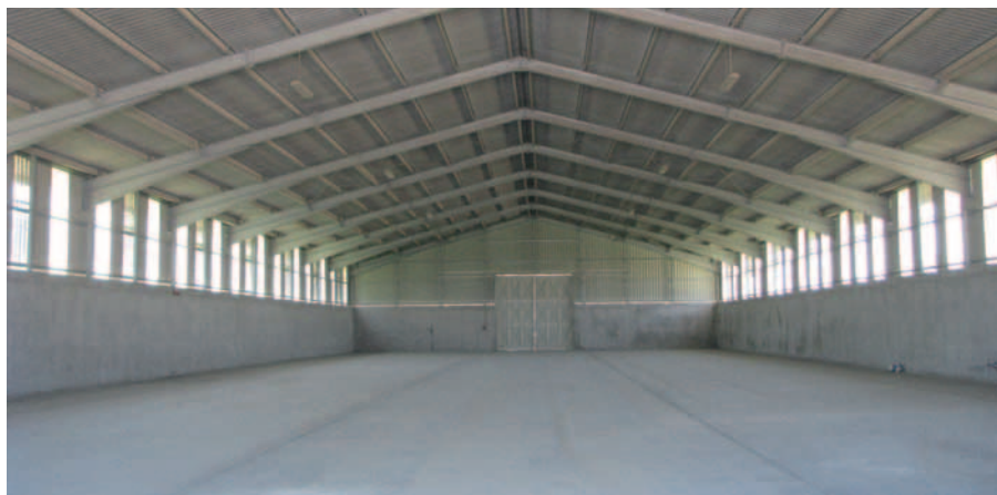
A termények tárolására szolgáló csarnoktároló
