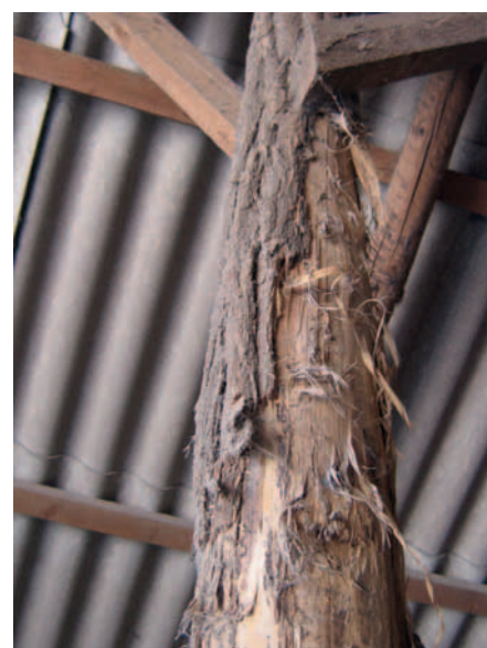
2. kép Kérgezetlen akácoszlop – a kártevők ideális búvóhelye
