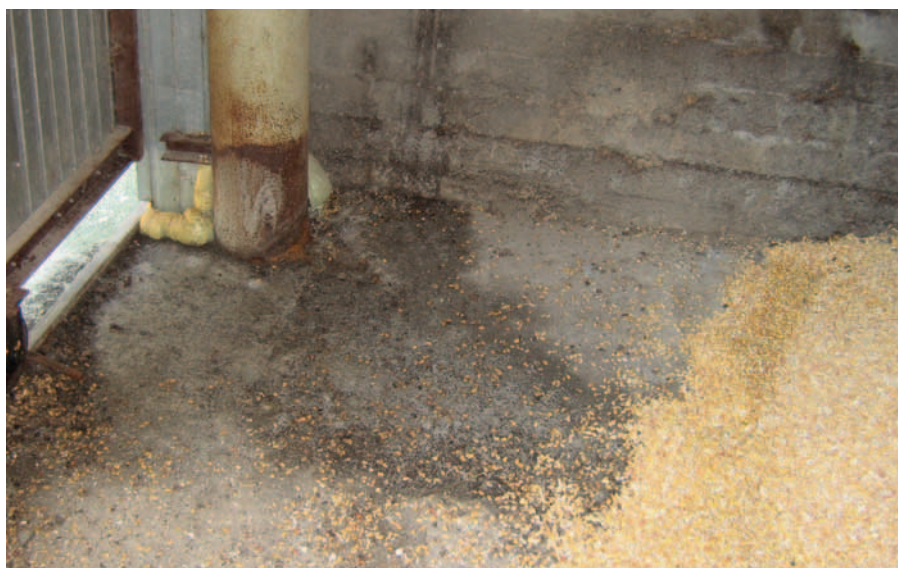
5. kép Alulról ázó aljzat. A PUR-hab szigetelés nem segít, a raktár a talaj szintje alatt van
