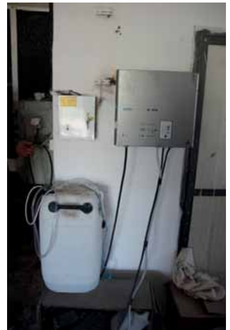
Az akkumulátortöltő és a desztillált víz pótlására szolgáló tartály, szivattyúval
